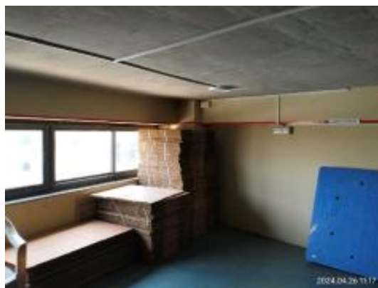
Packing material store.jpg
